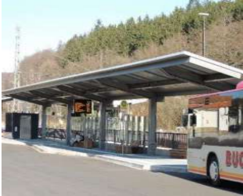
Bild 1: Neu gestalteter Bahnhof Türkismühle, der durch das Projekt Nahe-Hunsrück-Radweg vom Alltagsradverkehr deutlich besser erreicht werden soll
