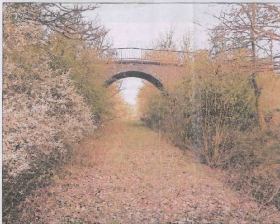
Viele Brücken auf der Strecke des Freizeitwegs müssen saniert werden. Das Foto zeigt die Brücke zwischen Asweiler und Wolfersweiler, die Gleise sind auf diesem 1. Abschnitt bereits demontiert. Foto: pdk
